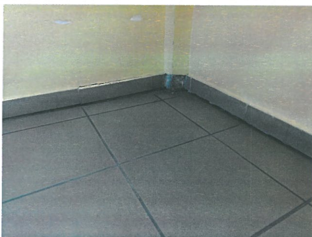
Fot. 3,4 – Lokalnie zapadnięta posadzka na wysokości około 15 mm.
