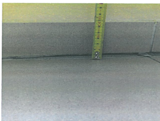
Fot. 25,26 – Lokalnie zapadnięta posadzka na wysokości około 13 mm.
