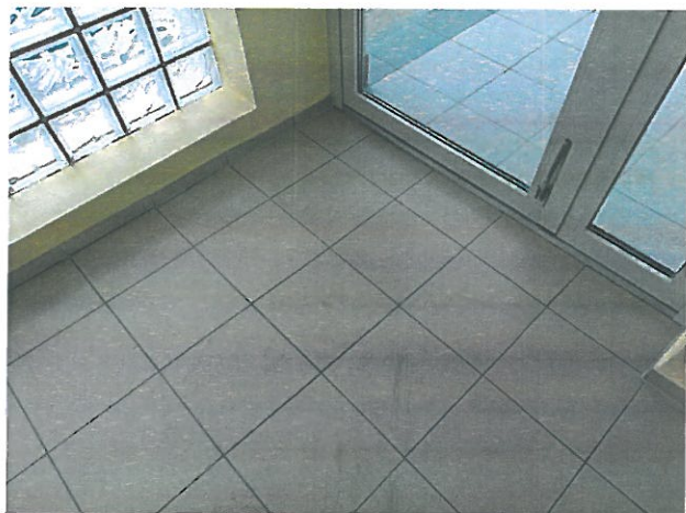
Fot. 19,20 – Miejscowo zapadnięta posadzka w klatce nr 24b.
