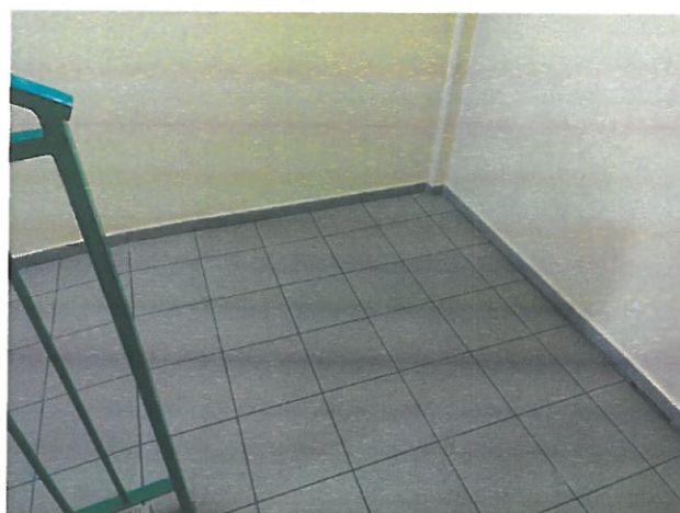
Fot. 13,14 – Miejscowo zapadnięta posadzka na wysokości podestu w klatce nr 24i.
