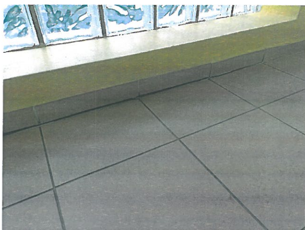
Fot. 25,26 – Lokalnie zapadnięta posadzka na wysokości około 13 mm.
