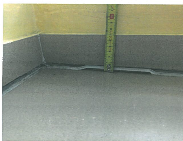
Fot. 23,24 – Lokalnie zapadnięta posadzka na wysokości około 14 mm.
