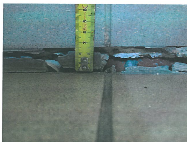
Fot. 15,16 – Lokalnie zapadnięta posadzka na wysokości około 26 mm.
