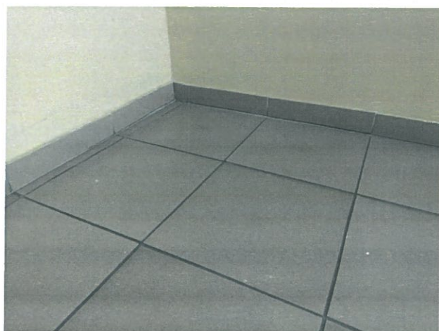
Fot. 23,24 – Lokalnie zapadnięta posadzka na wysokości około 14 mm.
