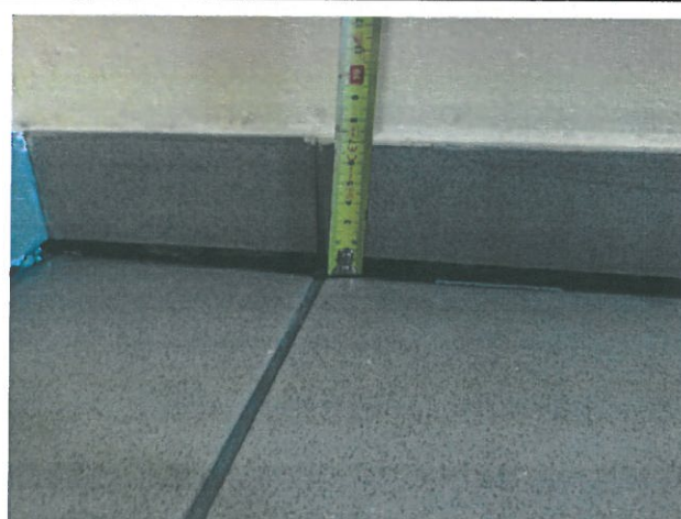
Fot. 5,6 – Lokalnie zapadnięta posadzka na wysokości około 12 mm.
