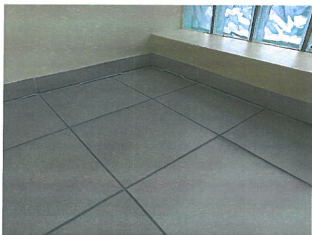
Fot. 21,22 – Lokalnie zapadnięta posadzka na wysokości około 16 mm.
