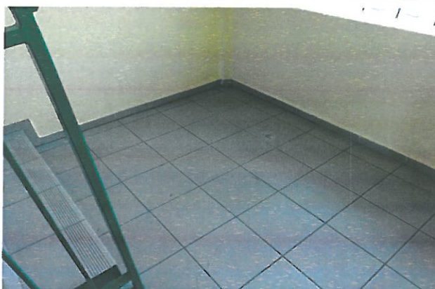
Fot. 1,2 – Miejscowo zapadnięta posadzka na wysokości podestu w klatce nr 24h.
