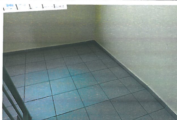
Fot. 1,2 – Miejscowo zapadnięta posadzka na wysokości podestu w klatce nr 24h.
