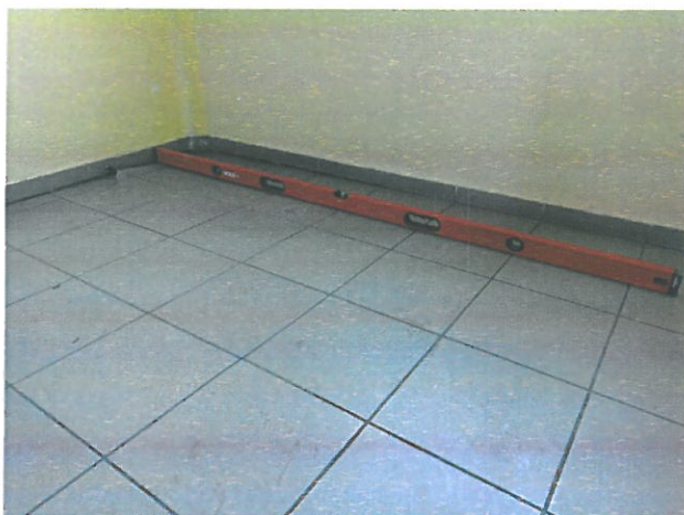
Fot. 7,8 – Odchylenie od kierunku poziomego posadzki na długości 2m sięgające 7 mm.
