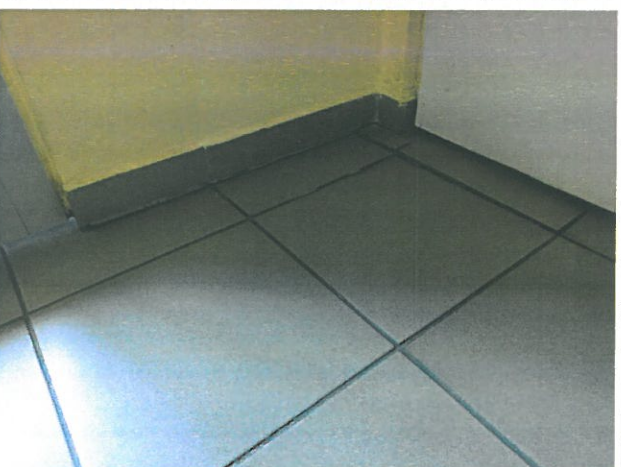
Fot. 11,12 – Lokalnie zapadnięta posadzka na wysokości około 12 mm.
