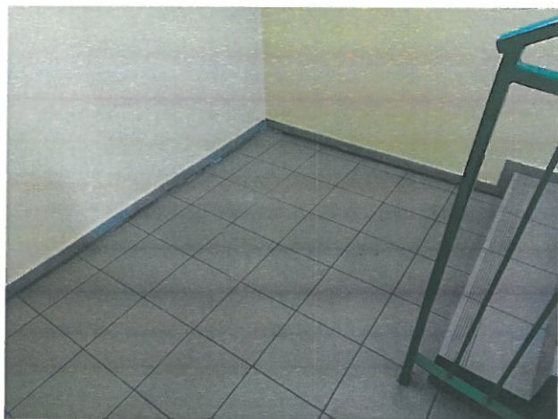
Fot. 13,14 – Miejscowo zapadnięta posadzka na wysokości podestu w klatce nr 24i.
