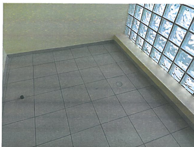
Fot. 19,20 – Miejscowo zapadnięta posadzka w klatce nr 24b.
