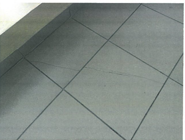
Fot. 29,30 – Powierzchniowe zarysowania oraz miejscowo odspojone płytki gresowe od podłoża.
