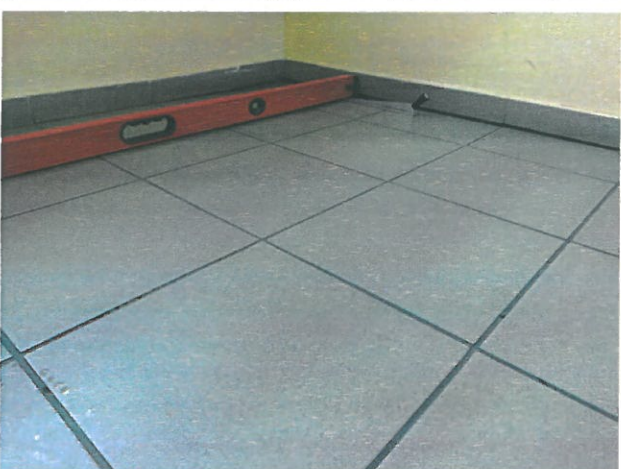
Fot. 9,10 – Odchylenie od kierunku poziomego posadzki na długości 2m sięgające 6,5 mm.
