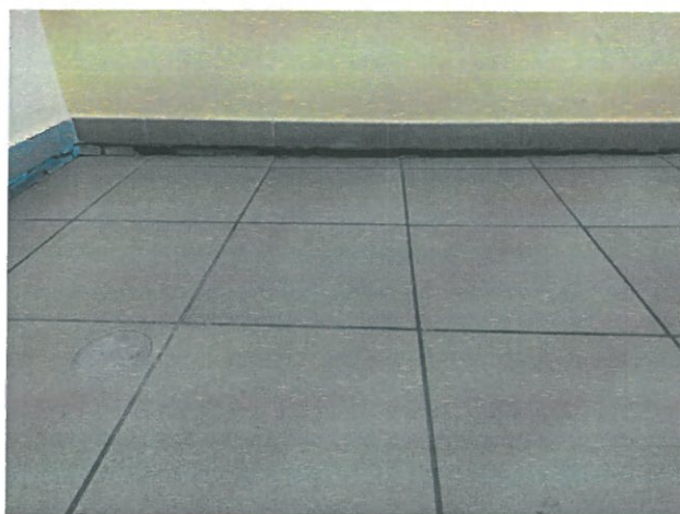
Fot. 15,16 – Lokalnie zapadnięta posadzka na wysokości około 26 mm.
