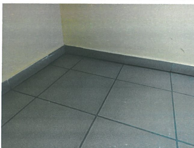
Fot. 5,6 – Lokalnie zapadnięta posadzka na wysokości około 12 mm.
