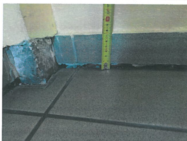
Fot. 3,4 – Lokalnie zapadnięta posadzka na wysokości około 15 mm.
