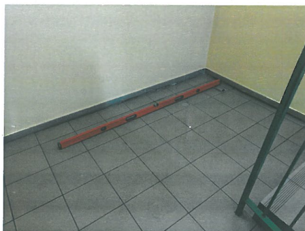
Fot. 17,18 – Odchylenie od kierunku poziomego posadzki na długości 2m sięgające 15 mm.
